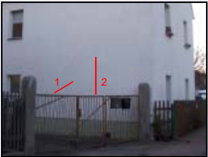
Sichtbarmachung eines alten Türbogens (Linie 1) des ehemaligen Eingangs zum Kellergewölbe und eines vermauerten Fensters (Linie 2).
