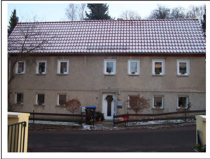
NW Vorderansicht / Eingang (straßenseitig)
